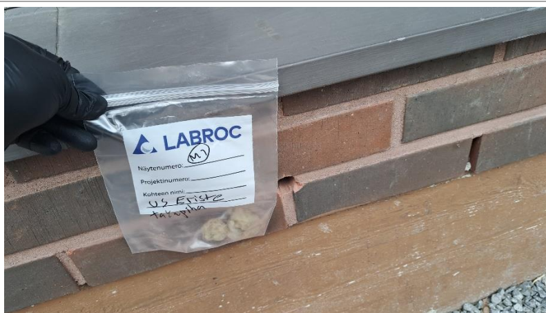
Näyte #M1: Ulkoseinän eristetila, ikkunan alta.
