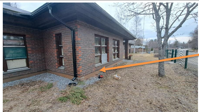
Näyte #M5: Ulkoseinän eristetila.
