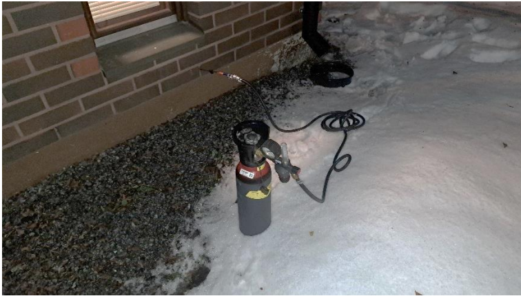
Varaston ulkoseinän merkkiainekaasutarkistus
