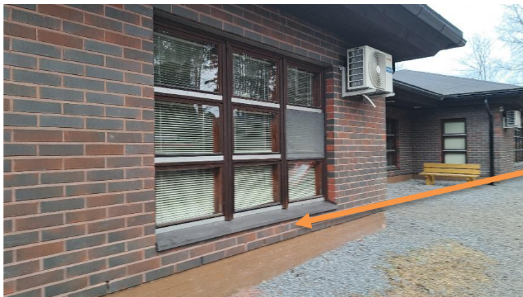
Näyte #M1: Ulkoseinän eristetila
