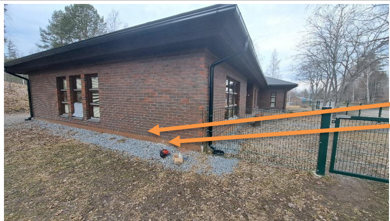
Näytteet #M3 ja #M4: Ulkoseinän eristetila ja sokkelihalkaisu.
